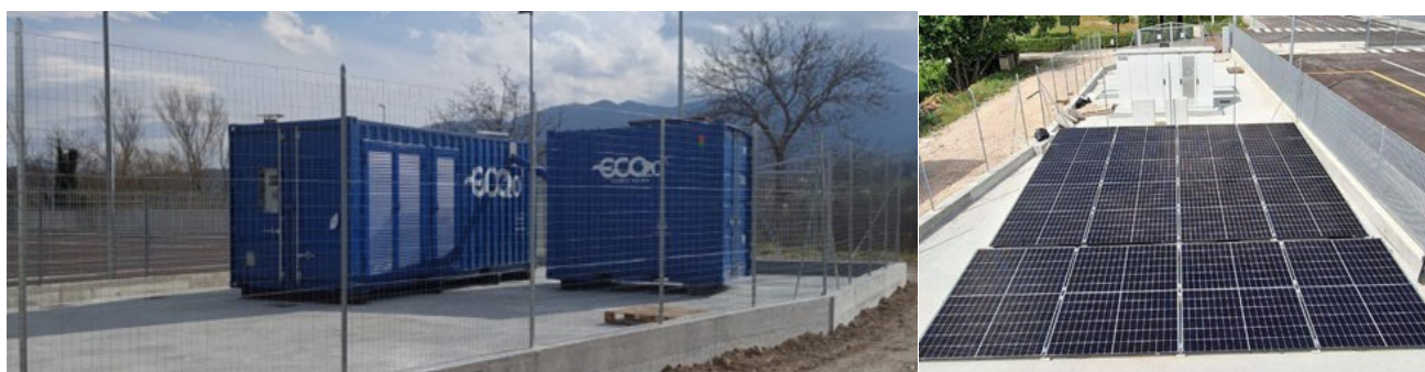
Figura 3: Installazione dell'impianto ECO20x per la produzione elettrica da biomassa e installazione del campo fotovoltaico.
